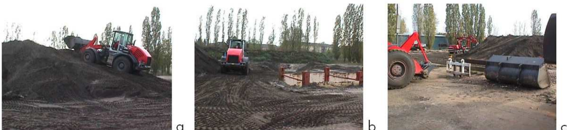
Abbildung 3.3: Szenen aus dem Arbeitsablauf, der auf Herstellergelände mit dem Radlader ausgeführt wurde. a: auf Erdhügel fahren und Erde abkippen; b: Rangieren um die Grube herum; c: Wechsel zwischen Schaufel und Gabel
